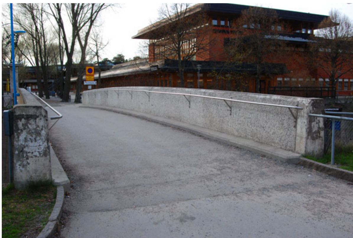
Gå över bron snett framför dig till vänster
