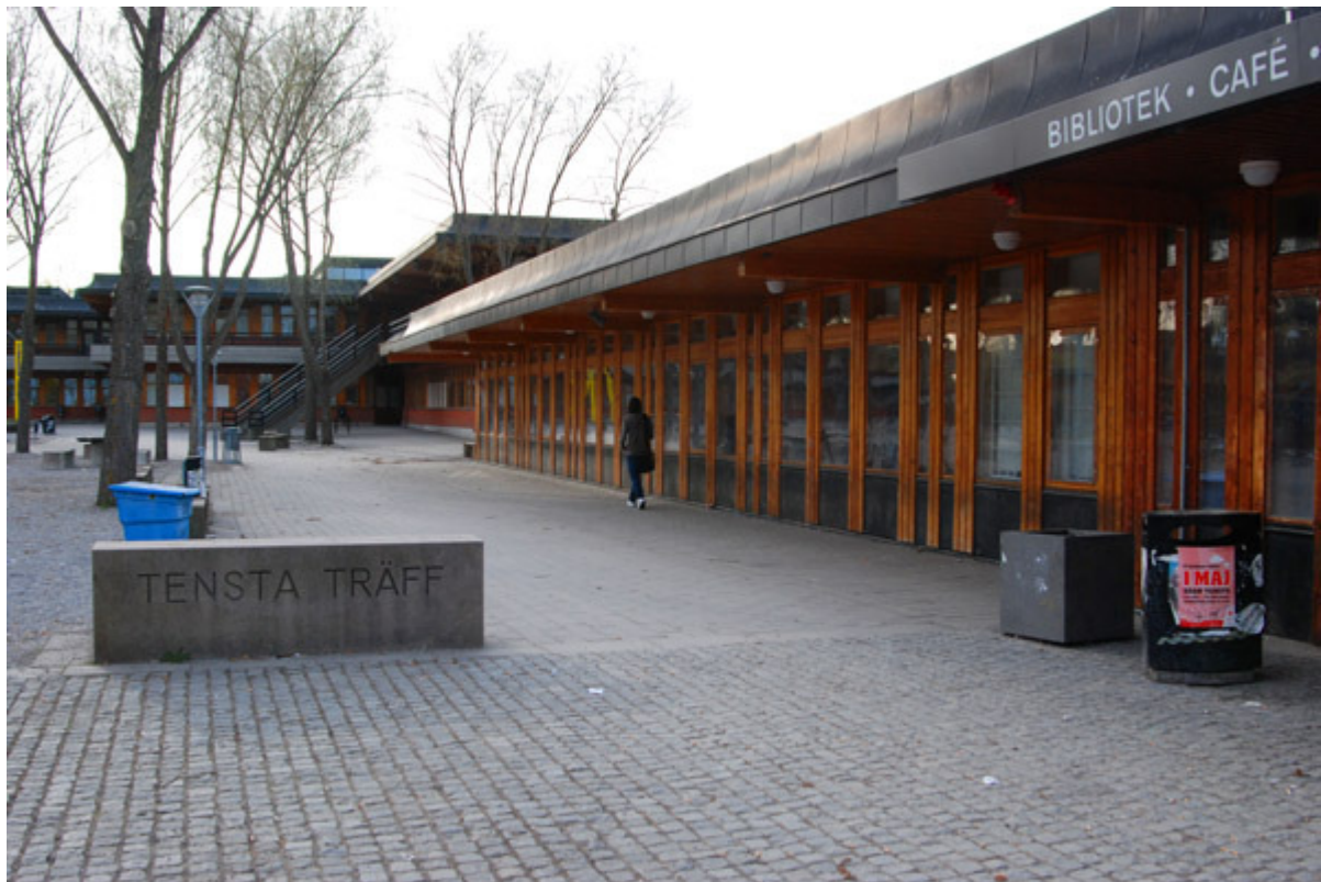
Ingång till Tensta Träff
